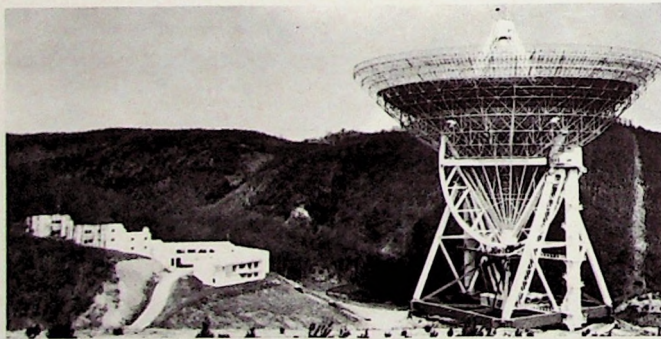
Das neue Radioteleskop mit den Betriebsgebäuden steht in einem Eifeltal bei Effelsberg. Die Kabine unterhalb der eigentlichen Antenne im Brennpunkt des Spiegels befindet sich bei senkrechter Stellung der Reflektorschale (Rotations-Paraboloid) 98 m über dem Erdboden Aufnahme: Krupp
